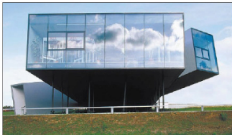
Österreichische Architektur: Das Betriebsgebäude VIT in Asperhofen vom Architekturbüro Querkraft.
